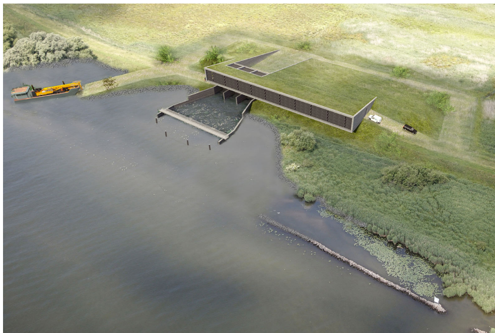
Figuur 2.2 Overzicht van het innamepompstation in de dijk van de Fortunapolder langs de Bergsche Maas. Links is de veerstoep te zien.
