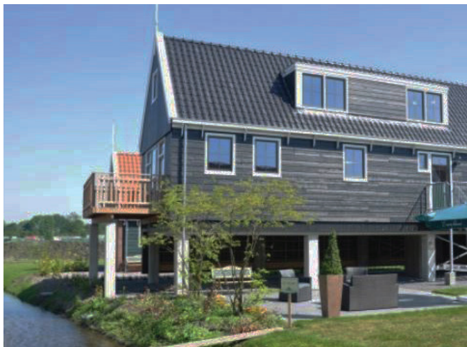
Nieuwbouw op palen
