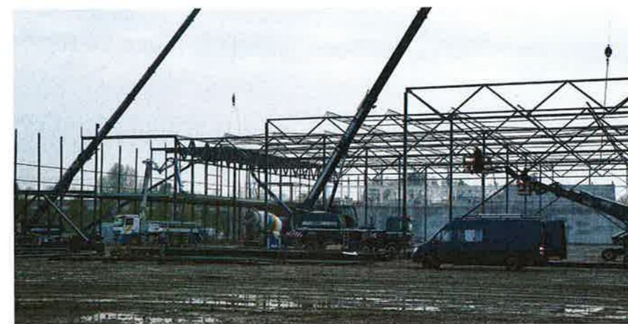
De constructie van de nieuwbouw staat overeind. Er komt een stalen gevel omheen.
