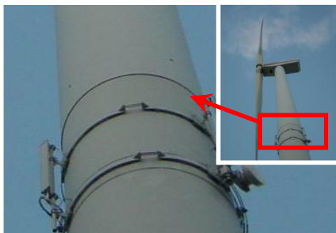
Afbeelding 3.3: Bestaande Slip-Joint verbinding op landturbine bij Scheveningen (NL)
