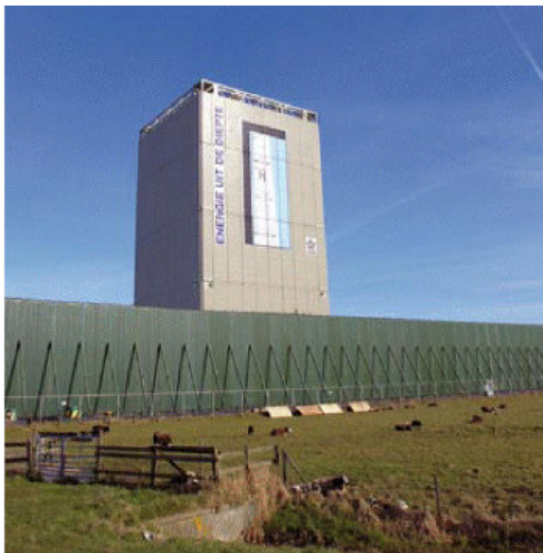
Figuur 4 Cocoon omkasting boorinstallatie
