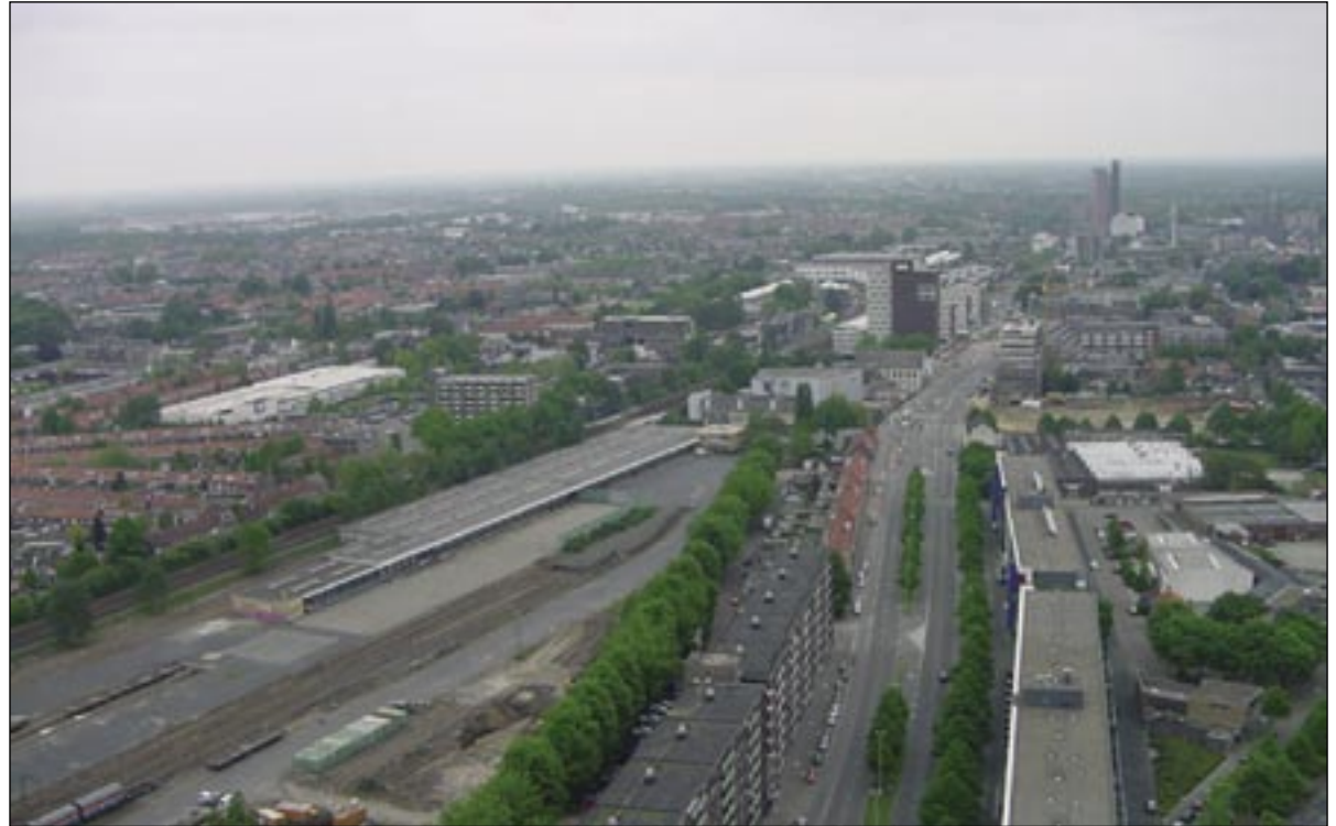
Spoorzone gezien vanaf WestPoint
