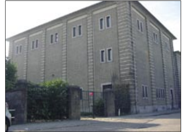
NUTS-gebouw aan de Lange Nieuwstraat 168-170
