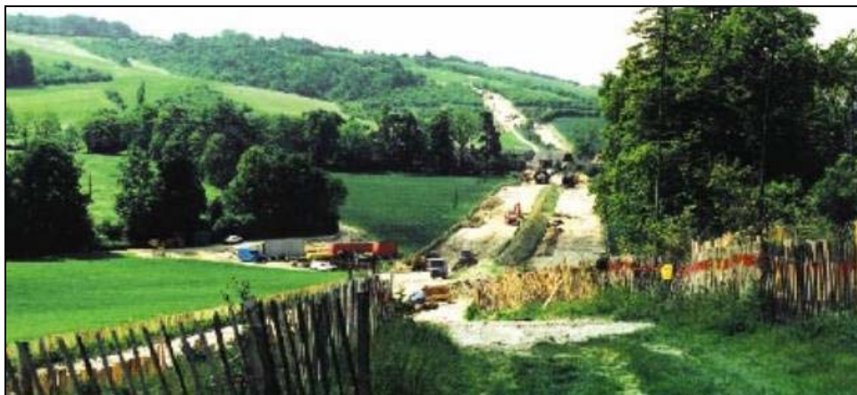
Figuur 5.2 Aanlegwerkzaamheden voor ondergrondse kabels
