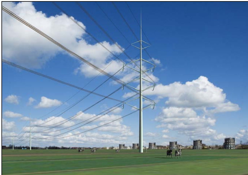
Figuur 5.1 Impressie van een nieuw masttype (hoekmast, indicatief ontwerp)
