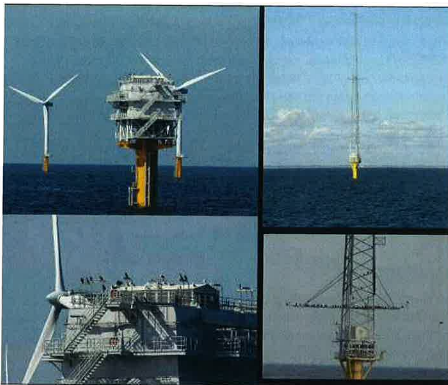
Figuur 6: Rustende Aalscholvers op het transformatorplatform van windpark Q7-Prinses Amalia (links, met linksonder een detail) en op de meteo-mast van windpark OWEZ (rechts, met rechtsonder een detail). Foto's Hans Verdaat.
