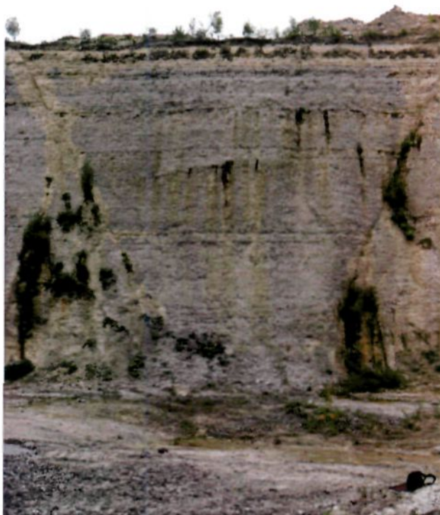
Figuur 4.3 Breuksystemen zoals zichtbaar in de diepe ontgraving in de ENCI-groeve
