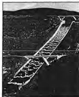
Um canal para canalizar a água que cai por cima do aterro de resíduos para uma barragem de controlo de poluição.
